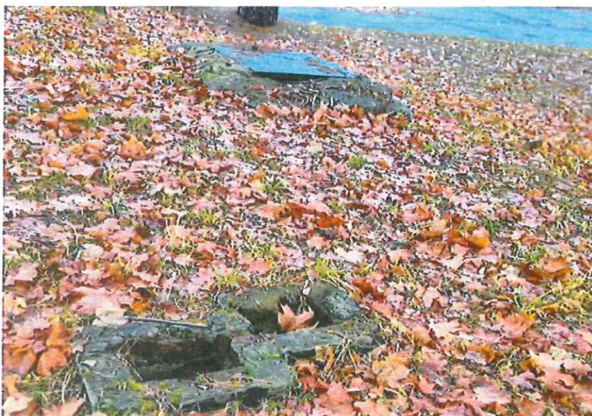
Brak instalacji wentylacyjnej- kanały częściowo zasypane,
